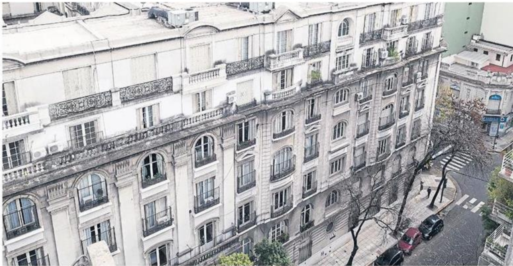
La expectativa es que deje de construirse sólo en los barrios más caros de la ciudad
